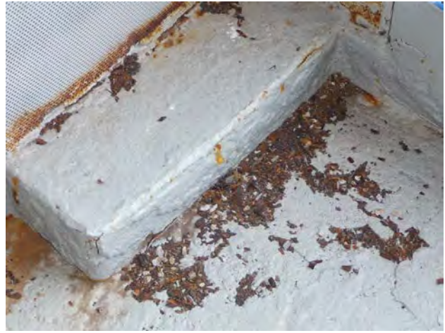
Air intake plenum (rust debris)
