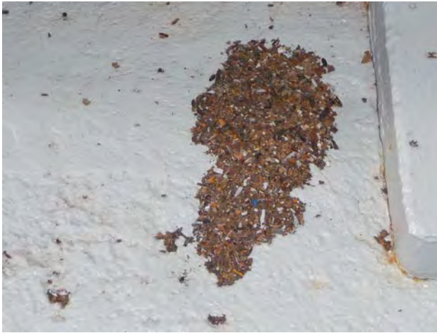
Air intake plenum (rust debris)
